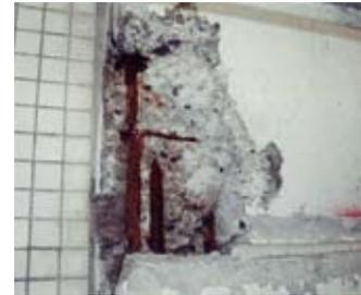
鉄筋腐食による爆裂
