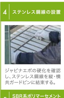
ジャピナエポの硬化を確認し、ステンレス鋼線を縦・横共ガードpinに結束する。
