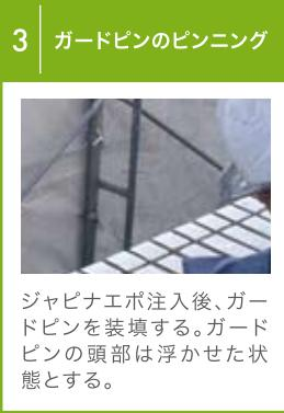
ジャピナエポ注入後、ガードpinを装填する。ガードpinの頭部は浮かせた状態とする。
