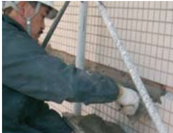
タイル撤去跡モルタル充填
